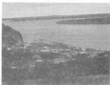
パイロットステーション
